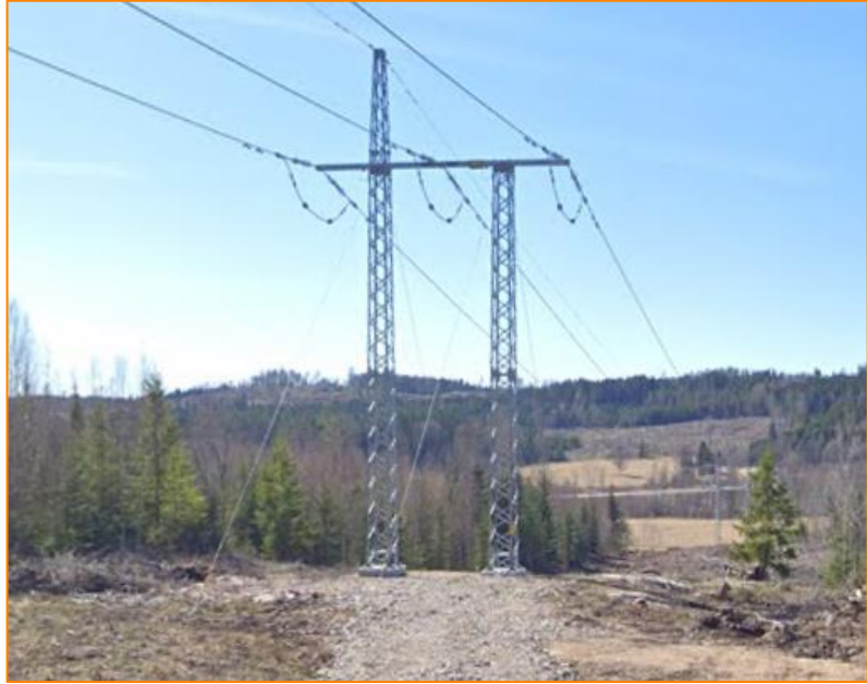
Figur 4. Portalstolpe i stål med en topplina.
