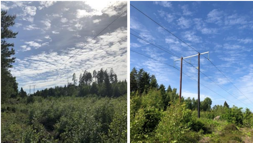
Figur 17. Platsen för anslutning till befintlig ledning L31. Foto: Rejlers Sverige AB.
