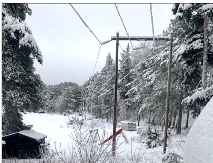
Figur 4. Portalstolpe tillhörande AL12S2.
