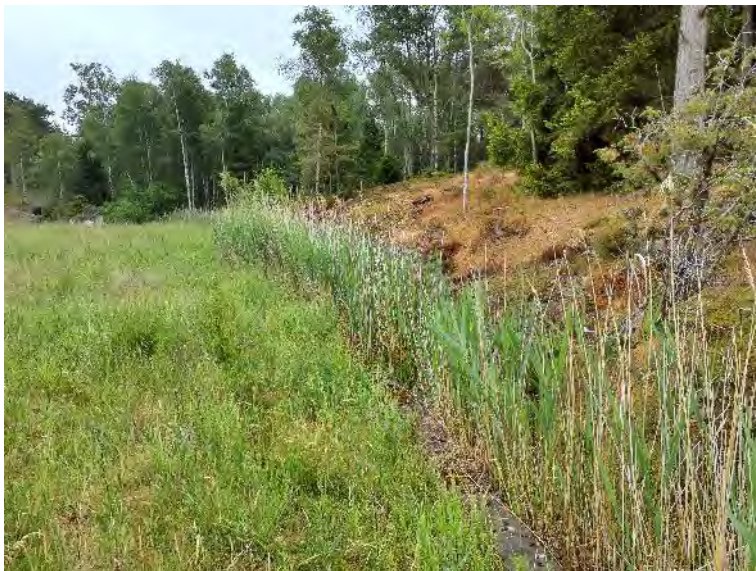
NVO 20: Öppet dike, klass 3 (preliminärt).
