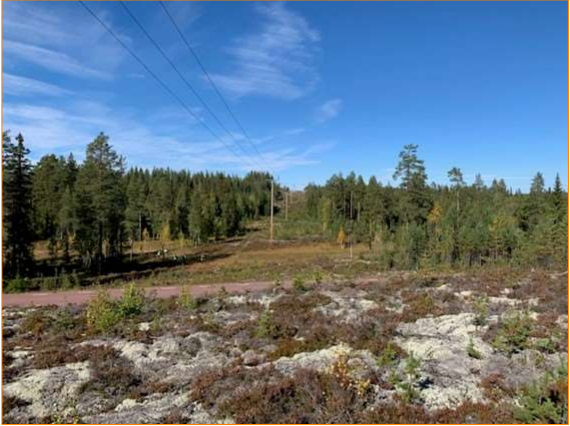
Figur 8. Befintlig 50 kV ledning mellan Sälen och Idre.
