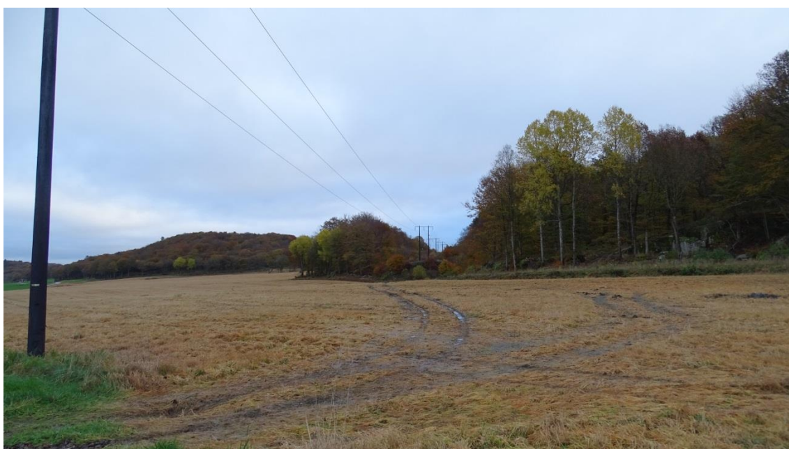
Figur 9 Befintlig ledning längs delsträcka DE1 och DE2 som passerar över åkermark och in i ett skogsparti som är Natura 2000 och nyckelbiotop. I figuren är ledningen uppförd med portalstolpar för att kunna ha långa spannlängder och minska påverkan på jordbruket.
