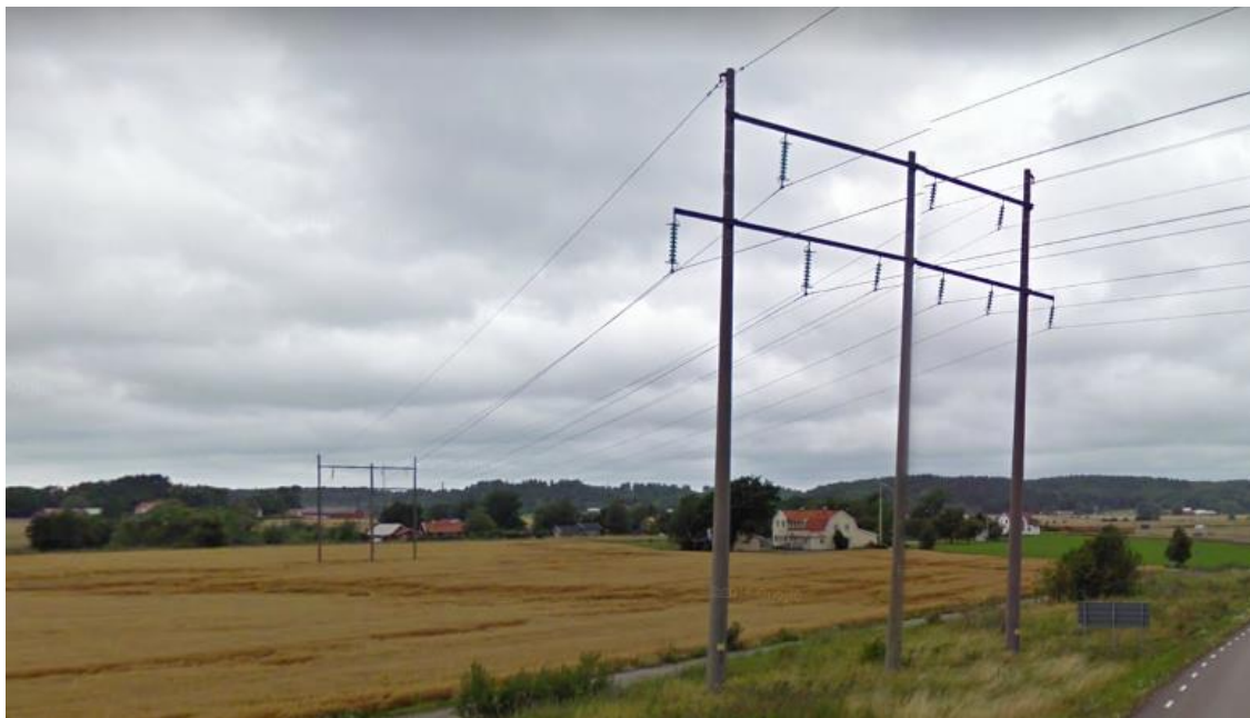
Figur 2 OL26 sambyggd med två andra ledningar söder om Varbergsvägen.
