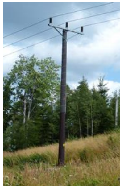
Figur 4 Exempel på enkelstolpe. Källa: Ellevio AB
