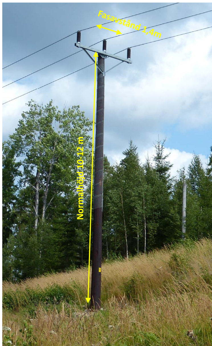
Figur 5. Ledningen kommer att utgöras av ca 10-12 meter höga trästolpar. Stolpen schaktas ned till ca 2 meters djup i mjukare mark.
