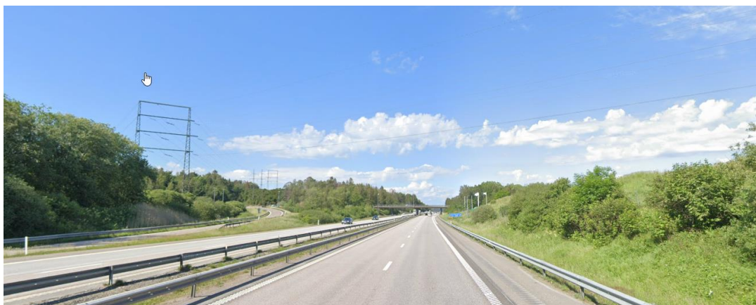
Figur 3. Befintlig stålstolpskonstruktion vid korsningen av väg E6. I stolpen hänger en 10 kV, en 50 kV och en 130 kV ledning. Nytt detaljplaneområde till höger i bild
